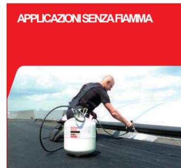
L'applicazione del prodotto senza necessità di fiamme libere è un requisito che abbiamo preso in considerazione nelle nostre tecniche di applicazione. Il metodo di giunzione del sormonto HERTALAN è implementato utilizzando la tecnologia ad aria calda e un giunto di giunzione EW che è già pronto in fabbrica. Un cordone di saldatura emergente indica una connessione di giunzione ideale e permanente sicura. In alternativa, le cuciture possono anche essere fatte aderire insieme.
